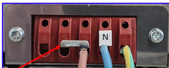
Pour le raccordement sur ligne monophasée, ne pas retirer le shunt
